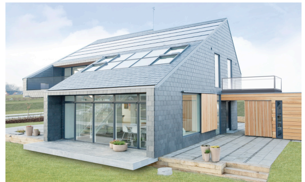
Bolig for livet er et plushus, hvor solvarme og solceller er blevet integreret i taget. Plushuset er tegnet af aart arkitekter i samarbejde med Velfac og opført i Lystrup ved Århus. Se www.velfac.dk eller www.aart.dk for yderligere informationer.
